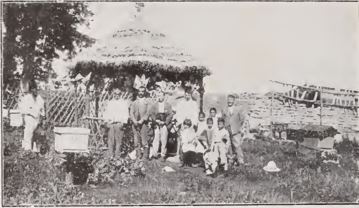
ESCUELA RURAL DE SAN LORENZO CUAUTENCO, ESTADO DE MÉXICO
